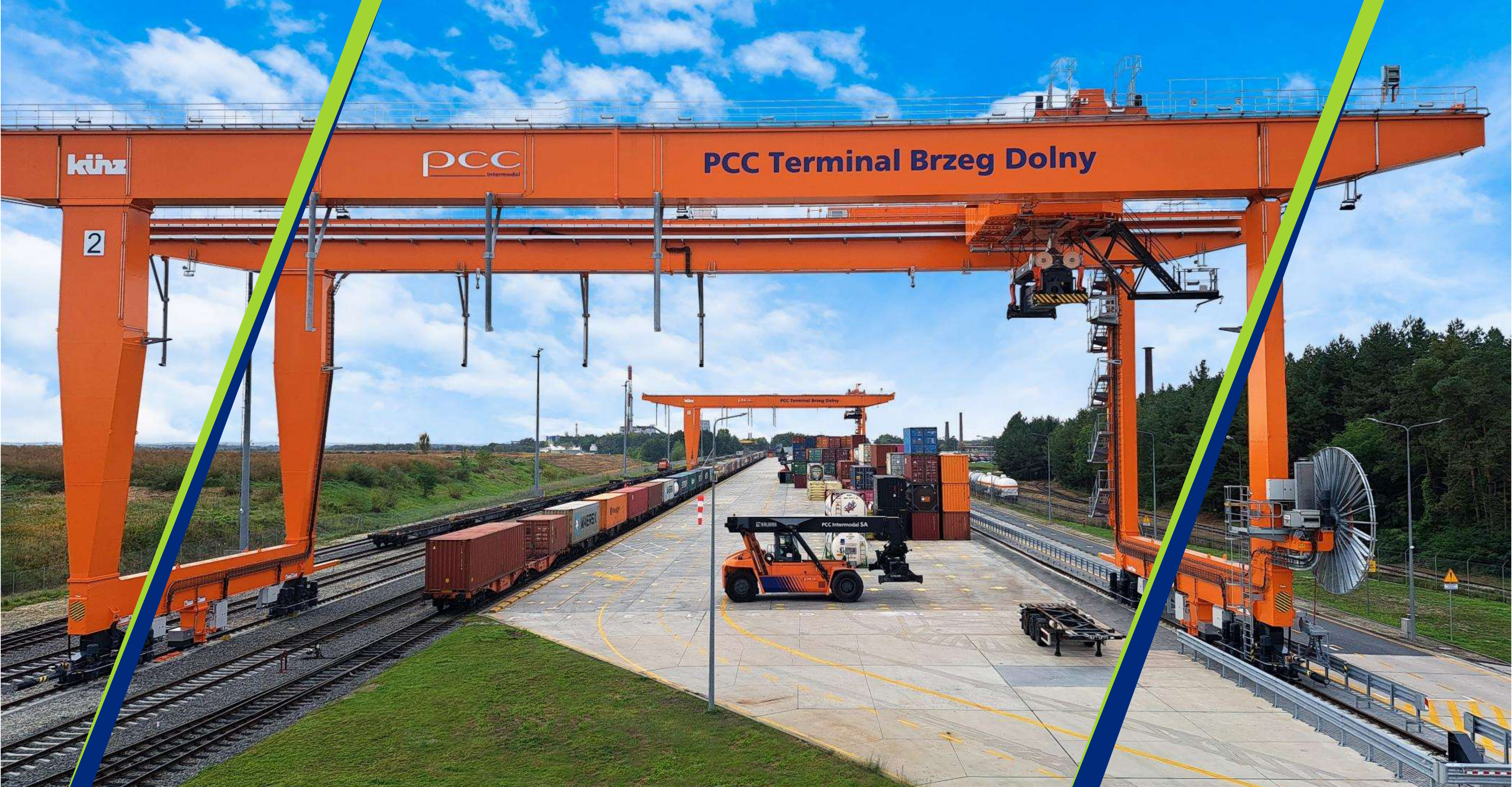
PCC BRZEG DOLNY TERMINAL
